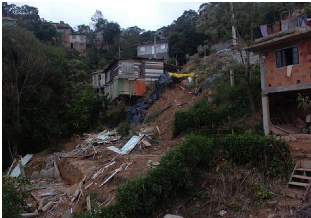
Foto 2.6: Deslizamento em ocupação no Setor Itaipu, 2009. Reportagem: Karen Lozi (Rádio Jornal 820 AM). Fonte: www.820am.com.br
