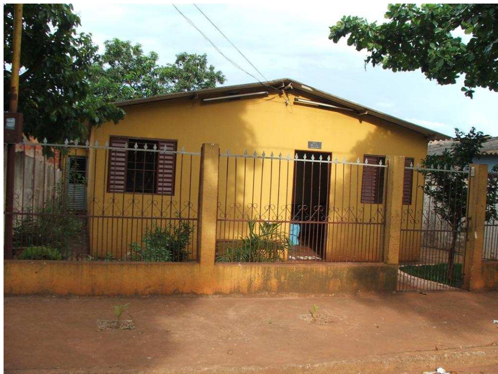
Foto 2.3: Casa da Vila Mutirão, 2006. Fonte: Banco de Experiências em Habitação – COMOB/2006.
